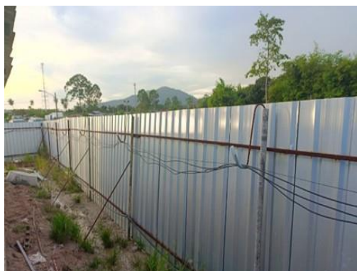
รูปที่ 8 การล้อมรั้วบริเวณพื้นที่ก่อสร้าง
