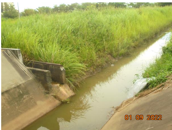
รูปที่ 12 รางระบายน้ำฝนชั่วคราวและรางระบายน้ำถาวร เชื่อมกับรางระบายน้ำฝนของโรงงานน้ำตาลสุรินทร์
