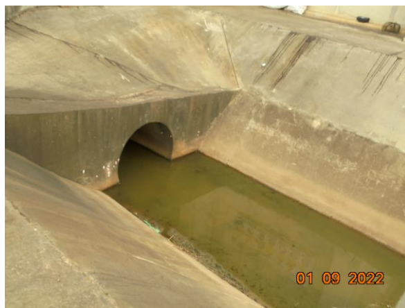
รูปที่ 12 รางระบายน้ำฝนชั่วคราวและรางระบายน้ำถาวร เชื่อมกับรางระบายน้ำฝนของโรงงานน้ำตาลสุรินทร์
