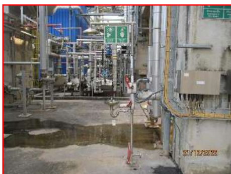
ภาพที่ 2-30 ช่างล้างตาและล้างกายฉุกเฉินในกระบวนการผลิต
