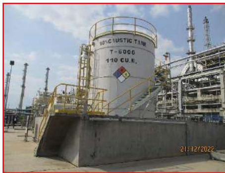
ภาพที่ 2-40 คันคอนกรีตกั้นถังสารเคมี (Bund Wall)
