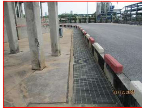
ภาพที่ 2-17 รางระบายน้ำฝนที่อาจปนเปื้อน
