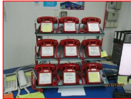
ภาพที่ 2-32 อุปกรณ์แจ้งเหตุฉุกเฉินในห้อง Control Room
