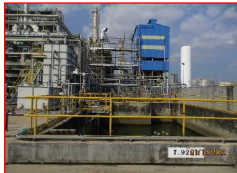
ภาพที่ 2-9 บ่อพักน้ำทิ้ง (Effluent Pond)
