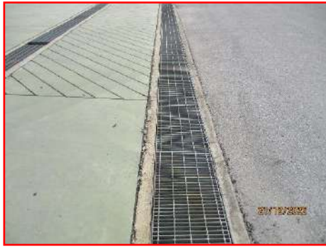
ภาพที่ 2-16 รางระบายน้ำฝนที่ไม่ปนเปื้อน
