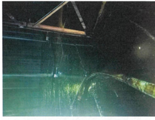
ผลการตรวจ : พบพนักงาน QC คลังสินค้า เข้าตรวจสอบภายในถังเก็บ โมลาส พบคราบน้ำตาลติดบริเวณผนังถังเก็บ โมลาส และบริเวณ พื้นถัง
