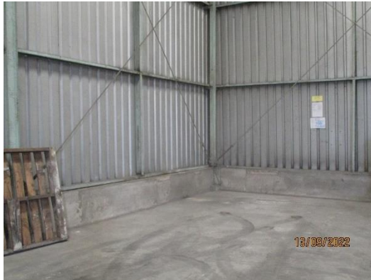
รูปที่ 114 คั่นกัน (Bund wall) บริเวณอาคารเก็บสารเคมี
