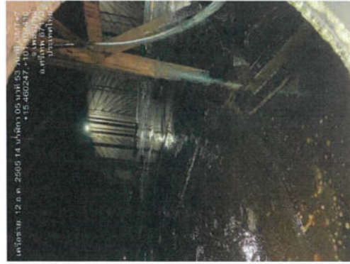
ผลการตรวจ : พบพนักงาน QC คลังสินค้า เข้าตรวจสอบภายในถังเก็บ โมลาส พบคราบน้ำตาลติดบริเวณผนังถังเก็บ โมลาส และบริเวณ พื้นถัง
