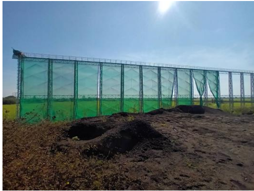
รูปที่ 36 การก่อสร้างติดตั้งเสาสำหรับติดตั้งแนวตาข่ายรอบลานเถ้า
