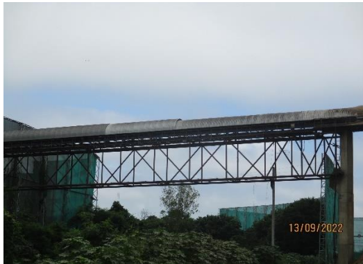
รูปที่ 15 ระบบสายพานลำเลียงแบบปิด
