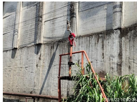
รูปที่ 113 หัวฉีดน้ำดับเพลิงรอบลานกองกากอ้อย
