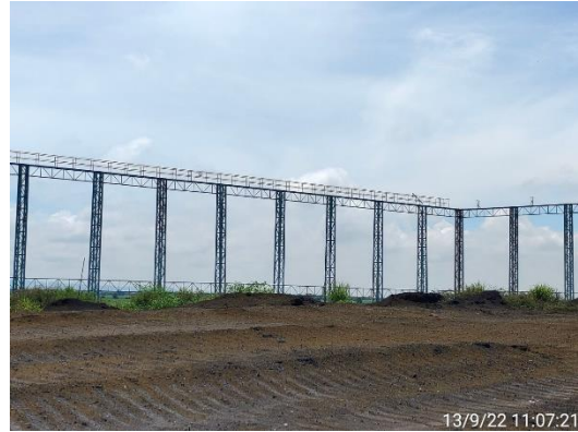
รูปที่ 36 การก่อสร้างติดตั้งเสาสำหรับติดตั้งแนวตาข่ายรอบลานเถ้า
