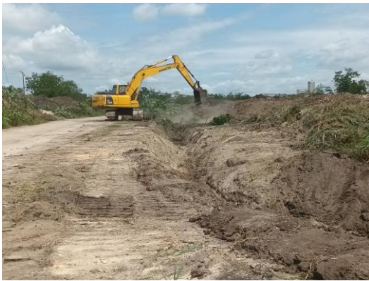
รูปที่ 50 การขุดลอกรางระบายน้ำรอบลานกองกากตะกอนฯ
