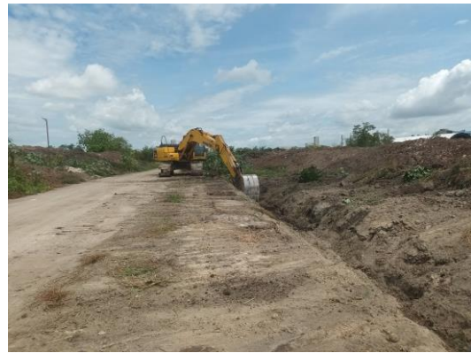
รูปที่ 50 การขุดลอกรางระบายน้ำรอบลานกองกากตะกอนฯ
