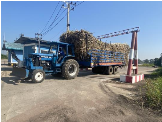
รูปที่ 76 คานควบคุมความสูงของอ้อย
