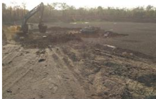
รูปที่ 65 การขุดลอกตะกอนระบบบำบัด
