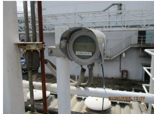
รูปที่ 12 การติดตั้ง pH Online บริเวณระบบบำบัดน้ำเสีย
