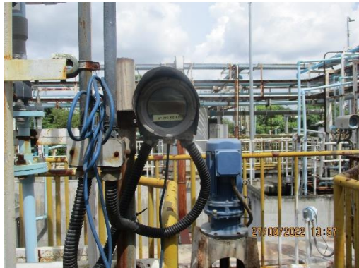
รูปที่ 12 การติดตั้ง pH Online บริเวณระบบบำบัดน้ำเสีย
