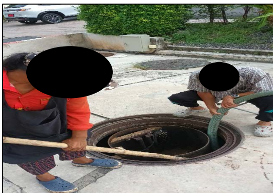
รูปที่ 2.2-22 สืบตะกอนน้ำเสียจากระบบบำบัดน้ำเสีย และขุดลอกท่อระบายน้ำ
