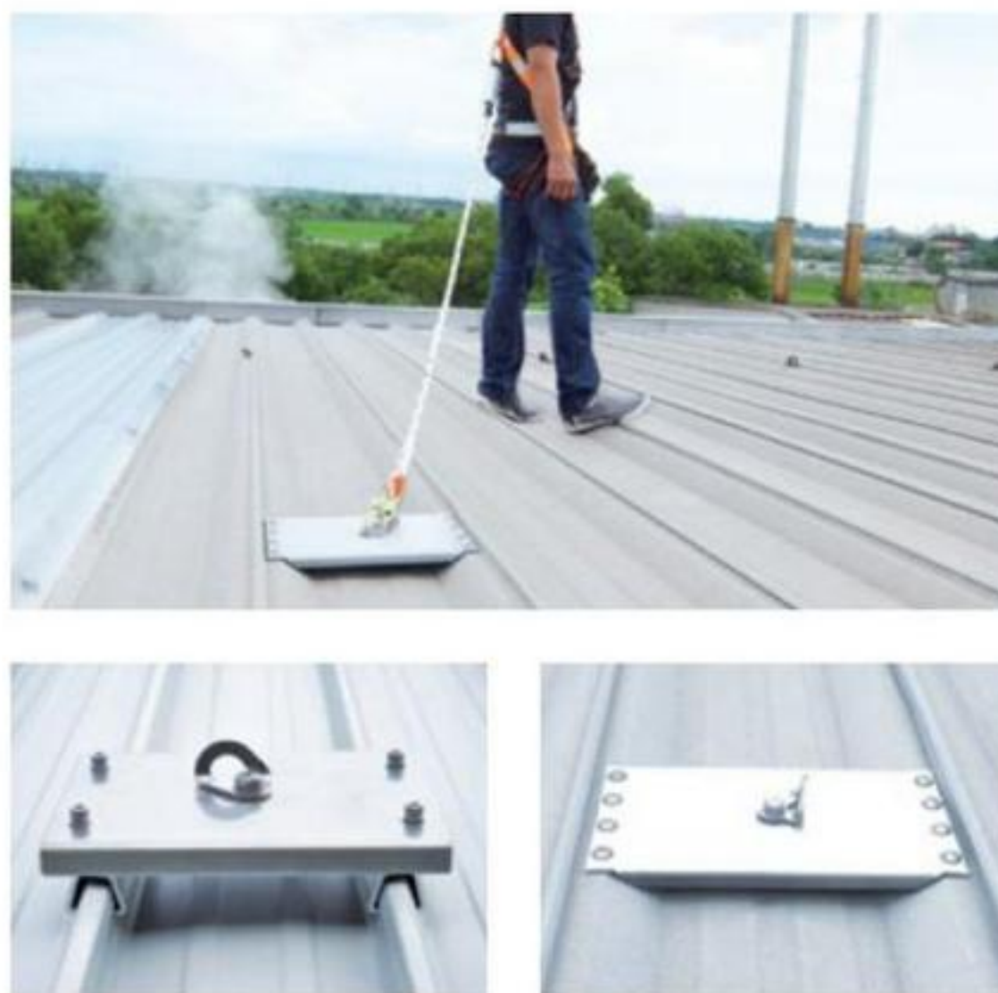
ตัวอย่างจุดยึด (Anchor Point) แบบเฉพาะจุดบนหลังคา มาตรฐาน EN 795
