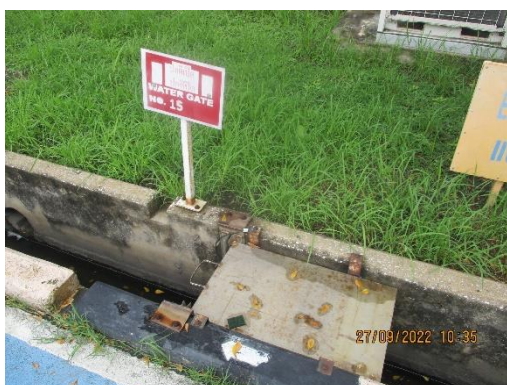
รูปที่ 22 ระบบระบายน้ำ และอุปกรณ์ปิดกั้นสิ่งกีดขวางการแพร่กระจายของสารเคมี กรณีเกิดเหตุรั่วไหล
