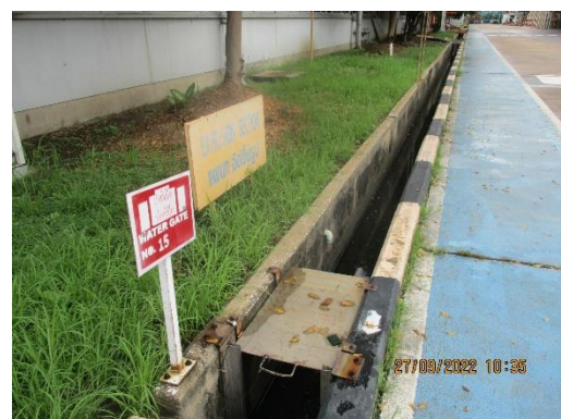
รูปที่ 22 ระบบระบายน้ำ และอุปกรณ์ปิดกั้นสิ่งกีดขวางการแพร่กระจายของสารเคมี กรณีเกิดเหตุรั่วไหล
