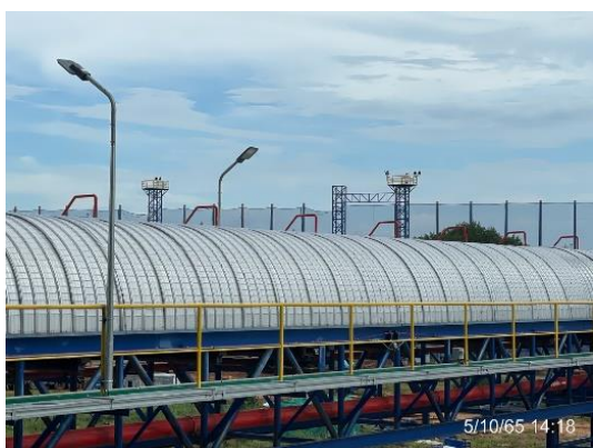
รูปที่ 14 ระบบสายพานลำเลียงแบบปิดครอบ
