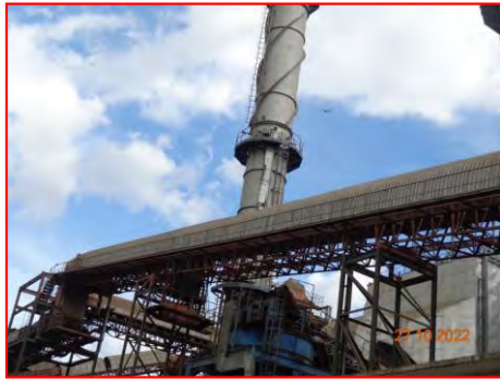
ภาพที่ 2.2-7 ระบบสายพานลำเลียงแบบปิด
