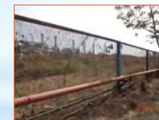
โครงสร้างเหล็กติดตั้งตาข่ายดักฝุ่นล้อมรอบพื้นที่ลานกองเถ้า
