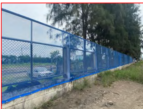
ภาพที่ 2.2-18 โครงสร้างเหล็กติดตาข่ายดักฝุ่น ล้อมรอบพื้นที่ลานกองถ่
