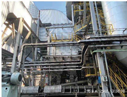
ภาพที่ 2-3 ระบบบำบัดมลพิษทางอากาศ
