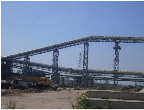
ภาพที่ 2-8 ระบบปิดครอบสายพานลำเลียงกากอ้อย
