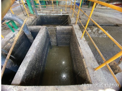
ภาพที่ 2-19 บ่อแยกน้ำและน้ำมัน
