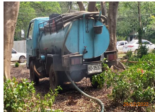
รูปที่ 2-7 การดูดไขมันจากบ่อดักไขมัน
