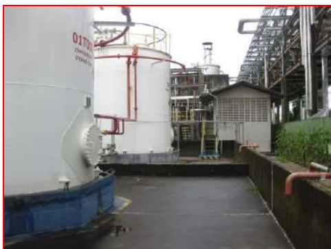
ภาพที่ 2.2-35 Dike กันรอบถังเก็บสารเคมี
