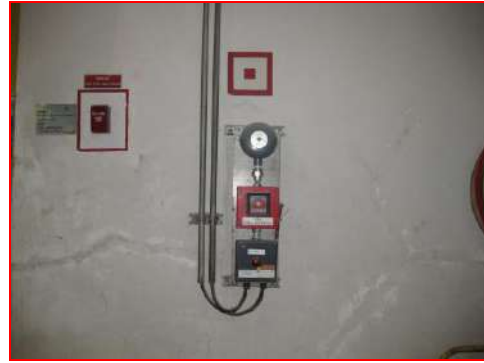
ภาพที่ 2.2-38 Fire Alarm แจ้งเหตุฉุกเฉิน
