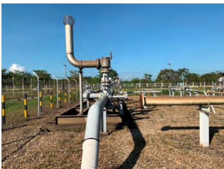
ภาพที่ 2.2-40 Pressure Relief Valve
