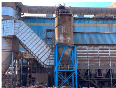
ภาพที่ 2.2-20 ไซโลเก็บรวบรวมฝุ่น จากระบบ Bag Filter House ของโรงงาน
