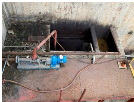
ภาพที่ 2.2-10 ระบบดักและแยกคราบน้ำมัน
