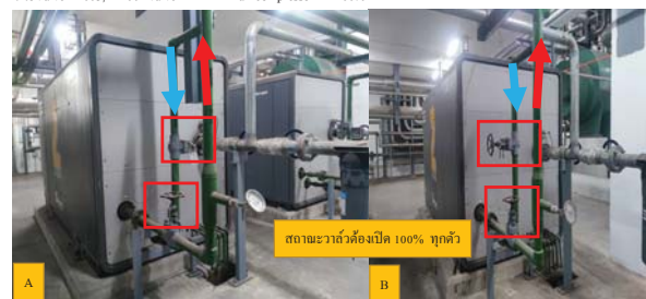
2.1.8 Valve AA003, AA004 valve ฝั่งทางออก air compressor B = 100%
