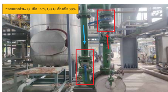
2.1.17 Valve ผึ่งขอเข้าเปิดที่ 100 % และขาออก BBD COOLER =50%
