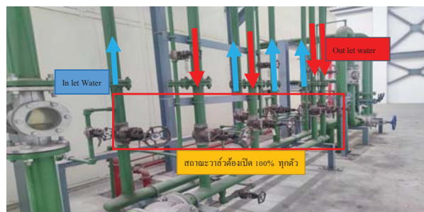
2.1.8 Valve AA003, AA004 valve ฝั่งทางออก air compressor B = 100%
