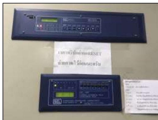
ภาพที่ 67 ติดตั้งอุปกรณ์ป้องกันป้องกันกระแสเกิน (Over current relays), อุปกรณ์วัดอุณหภูมิของขดลวด, อุปกรณ์ป้องกันแรงดันไฟฟ้าสูงเกิน, อุปกรณ์ป้องกันกำลังไฟฟ้าย้อนกลับ, อุปกรณ์ป้องกันการรั่วไหลของแรงดันไฟฟ้า
