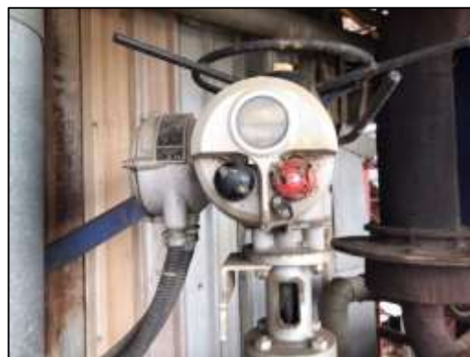
ภาพที่ 66 ติดตั้งชุด Bypass valve เพื่อลดความดันของไอน้ำ
