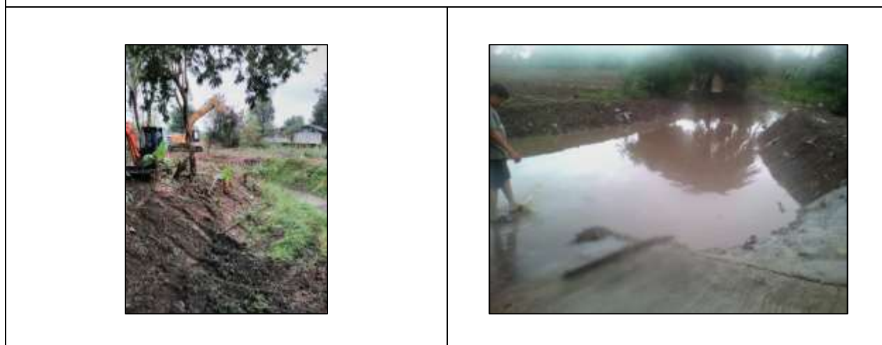
ภาพที่ 40 ตรวจสอบซ่อมบำรุงคันบ่อบำบัดน้ำเสียก่อนเข้าช่วงฤดูฝน
