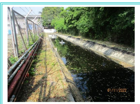
รูปที่ 3-16 บ่อพักคอนกรีตป้องกันน้ำล้นจากคลองสำโรง
