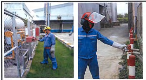
3. สวิตเตอร์และพนักงานปิดวาล์วและดึงวาล์วฉุกเฉิน
