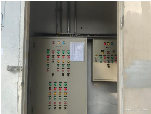
รูปที่ 35 ตู้ควบคุมระบบบำบัดน้ำเสีย
