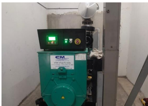
รูปที่ 17 เครื่องกำเนิดไฟฟ้าสำรอง
