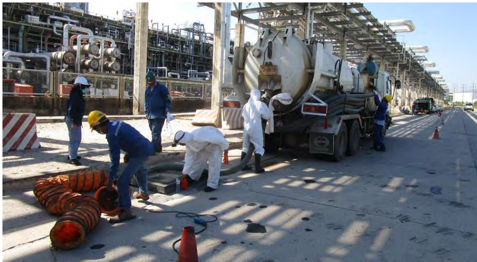
ภาพการทำงานลอกท่อระบายน้ำ พื้นที่ฝัง IP บริเวณถนน A, C-2 และถนน D
