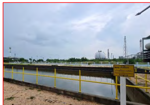
ภาพที่ 2.2-4 บ่อรองรับน้ำทิ้งจากระบบบำบัดน้ำ เสียส่วนกลาง (Receiving Pond)
