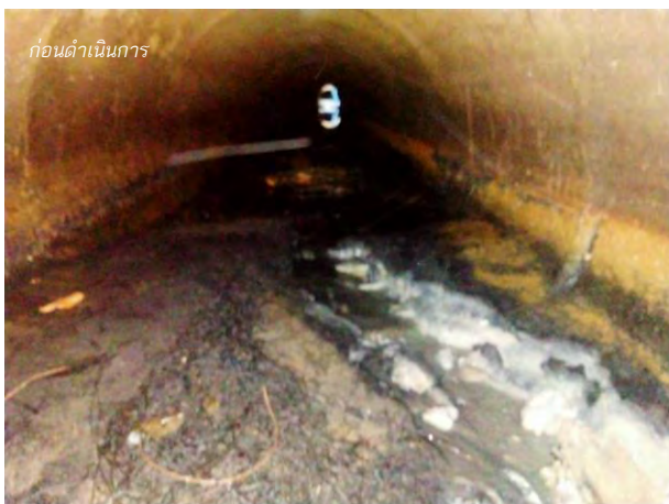
ภาพการทำงานลอกท่อระบายน้ำ พื้นที่ฝั่ง IP บริเวณถนน A, C-2 และถนน D
