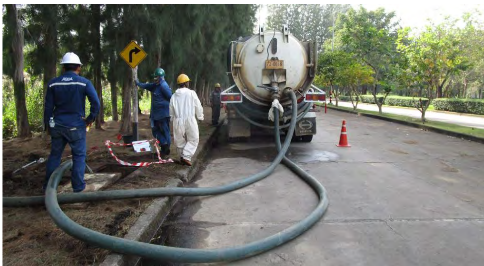
ภาพการทำงานลอกท่อระบายน้ำ พื้นที่ฝัง IP บริเวณถนน A, C-2 และถนน D
