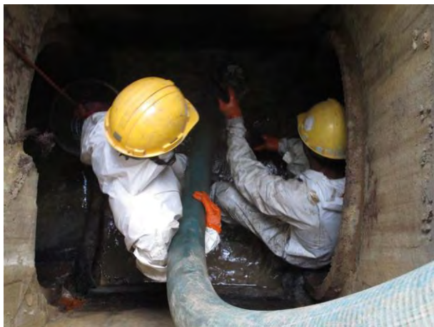
ภาพการทำงานลอกท่อระบายน้ำ พื้นที่ฝั่ง IP บริเวณถนน A, C-2 และถนน D
