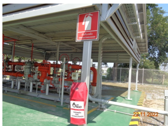
รูปที่ 3-6 อุปกรณ์ดับเพลิง และวาล์วควบคุม ประจำสถานีก๊าซ
