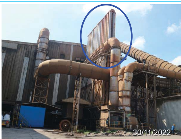
รูปที่ 3-5 ระบบ Natural Cooler ที่ติดตั้งเพิ่มเติม
