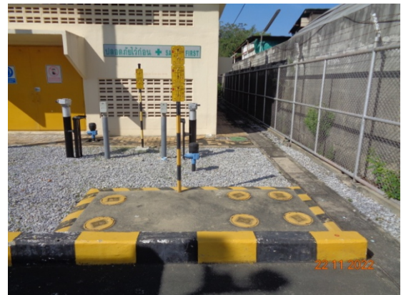
รูปที่ 3-6 อุปกรณ์ดับเพลิง และวาล์วควบคุม
