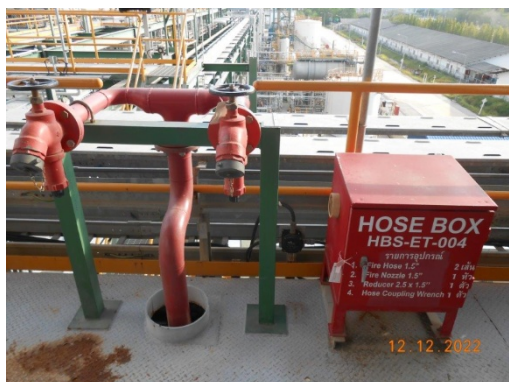
รูปที่ 50 Water Hydrants (Indoor & Outdoor)
