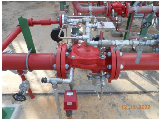
รูปที่ 47 Deluge Valve System
