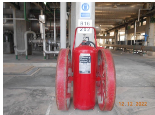
รูปที่ 49 Wheeled Fire Extinguisher
