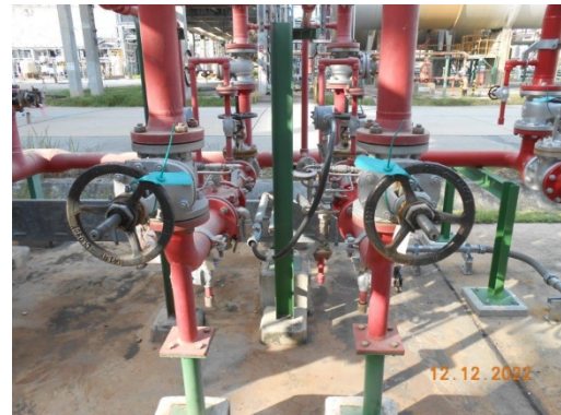
รูปที่ 47 Deluge Valve System
