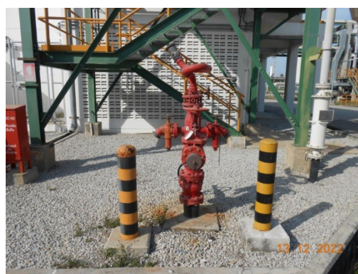
รูปที่ 46 Water Hydrants with Monitors
