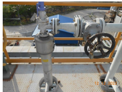
รูปที่ 60 Safety Valve (Relief & Vacuum Valve และ Shutoff Valve)
