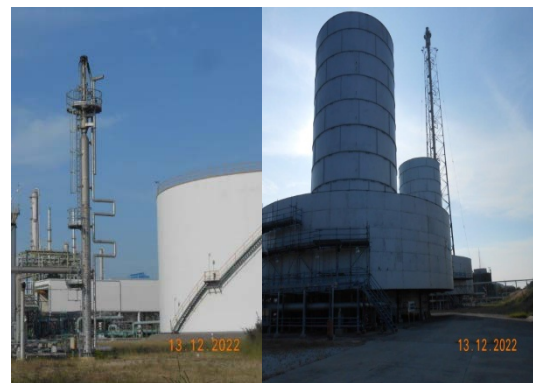
รูปที่ 4 หอเผาความดันต่ำ หอเผาความดันสูง และหอเผาชนิด EGF
