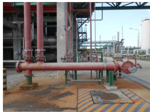
รูปที่ 45 Wet Spray System
