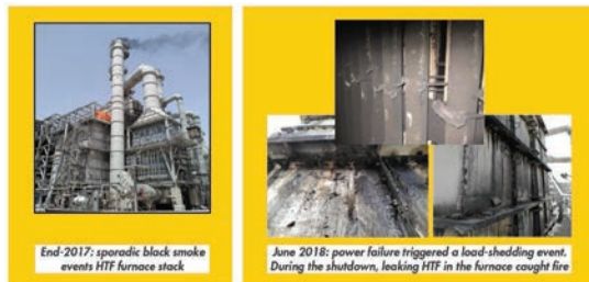
รูปที่ 1 Fire in Heat Transfer Fluid Furnace
