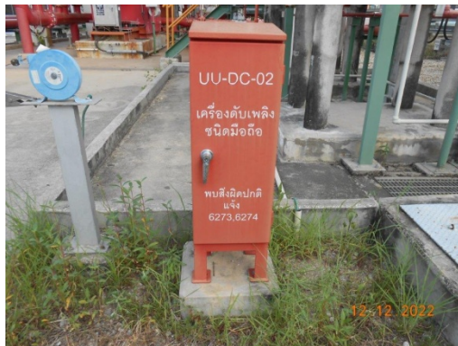
รูปที่ 51 Fire Extinguishers
