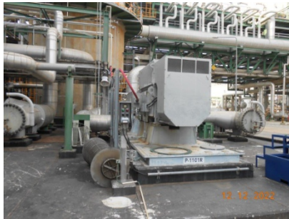
รูปที่ 57 Electric Fire Pump
