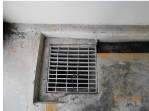
รูปที่ 26 บ่อรวบรวมน้ำเสียที่หกรั่วไหลจาก อาคารเก็บกากของเสีย
