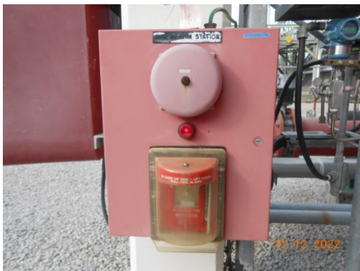
รูปที่ 53 Manual Fire Alarm
