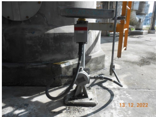
รูปที่ 42 Fixed Gas Detector
