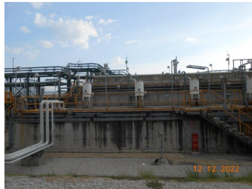
รูปที่ 8 ถังปรับสมดุล (Equalization Tank)
