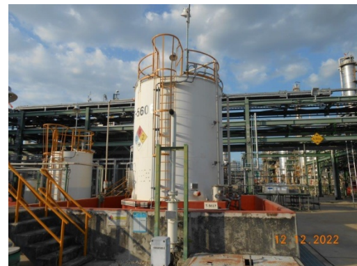
รูปที่ 41 ถังคอนกรีตล้อมรอบถังเก็บสารเคมี
