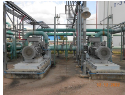
รูปที่ 58 Electric Jockey Pump
