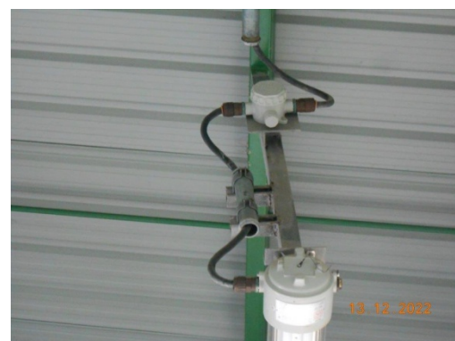
รูปที่ 30 Heat Detector
