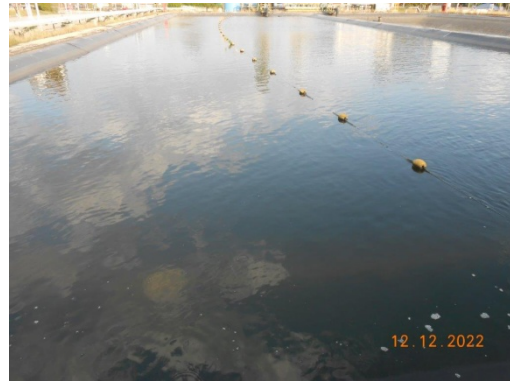
รูปที่ 14 บ่อพักน้ำทิ้งขนาด 1,200 ลบ.ม.
