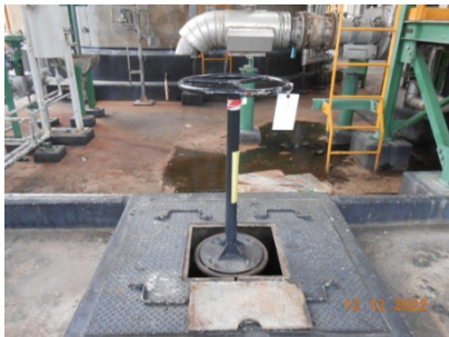
รูปที่ 61 วาล์วตัดแยกระบบ
