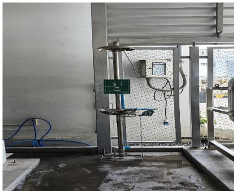
รูปที่ 22 ฝักบัวฉุกเฉินและอ่างล้างตา
