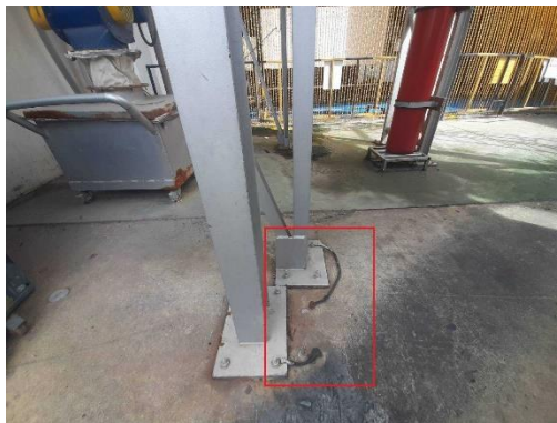
รูปที่ 30 ระบบสายดิน
