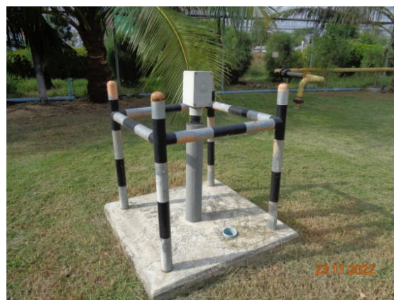
รูปที่ 3-2 ระบบวาล์วใต้ดินเพื่อสามารถตัดแยกระบบกรณีเกิดเหตุฉุกเฉิน
