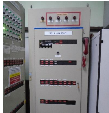
ภาพที่ 2-20 Gas Detector และแผงแสดงสัญญาณในห้องควบคุม
