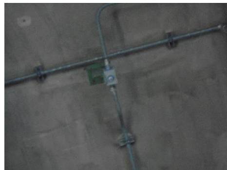
ภาพที่ 2-22 Heat Detector
