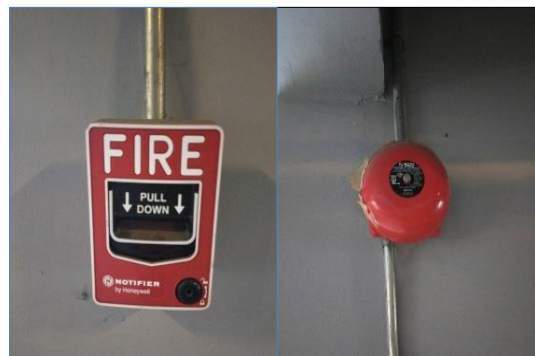
ภาพที่ 19 Alarm Bell, Manual Station
