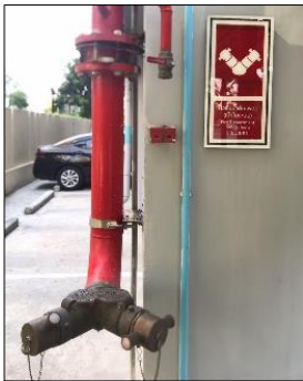
ภาพที่ 33 ป้ายบอกทางหนีไฟ, หัวรับน้ำดับเพลิง
