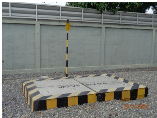
รูปที่ 3-8 ระบบบวล์ใต้ดินเพื่อสามารถตัดแยกระบบกรณีเกิดเหตุฉุกเฉิน
