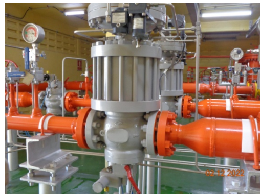
รูปที่ 3-7 วาล์วควบคุมแรงดันก๊าซ (Pressure Control Valve) บริเวณสถานีก๊าซ OTS
