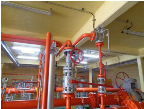
รูปที่ 3-6 วาล์วควบคุมแรงดันเกินชั่วคราว (Pressure Relieve Valve) บริเวณสถานีก๊าซ OTS
