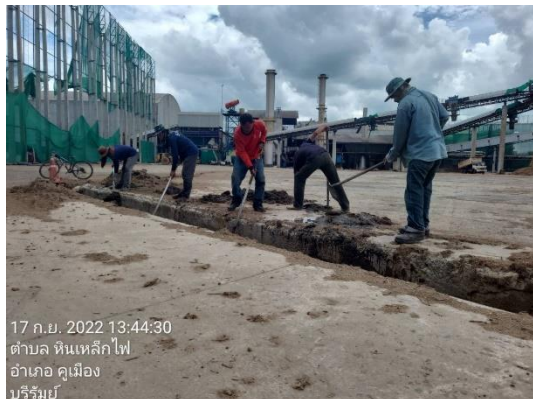
รูปที่ 31 กิจกรรมการขุดลอกตะกอนจากรางระบายน้ำ
