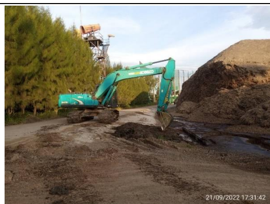
รูปที่ 19 การขุดลอกรางระบายน้ำรอบลานกองเก็บเชื้อเพลิง
