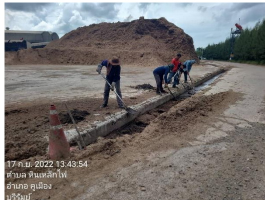
รูปที่ 31 กิจกรรมการขุดลอกตะกอนจากรางระบายน้ำ
