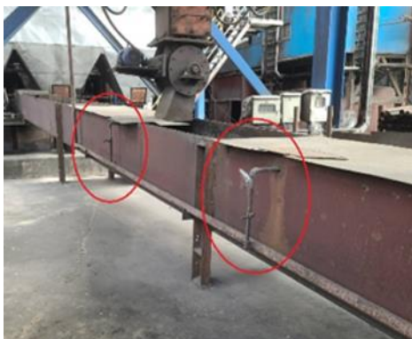
รูปที่ 6 ระบบสเปรย์น้ำเพื่อลดการฟุ้งกระจายของฝุ่นละออง
