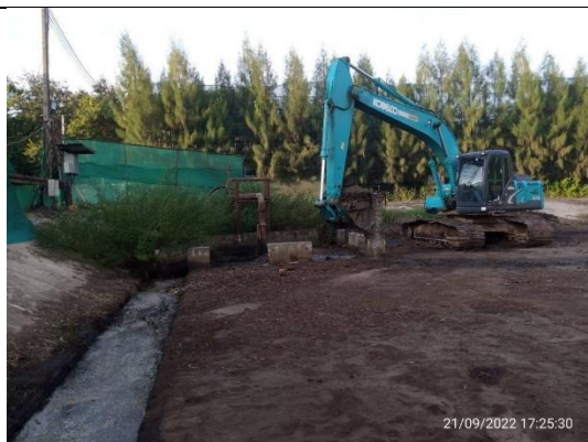
รูปที่ 19 การขุดลอกรางระบายน้ำรอบลานกองเก็บเชื้อเพลิง
