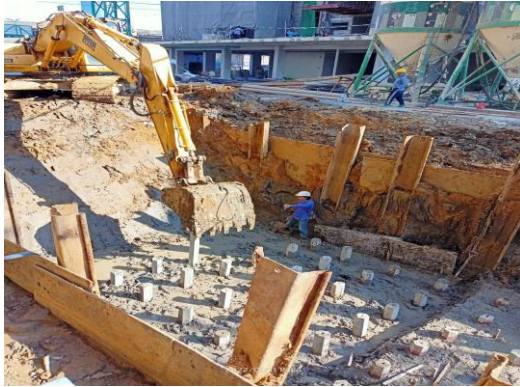
รูปที่ 19 กำแพงกันดิน (Sheet Pile)
