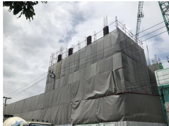
รูปที่ 16 รั้ว Mesh Sheet กันฝุ่น
