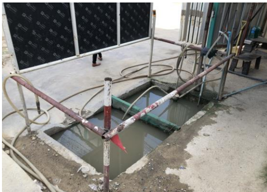
รูปที่ 21 บ่อพักน้ำก่อนระบายออกนอกพื้นที่โครงการ
