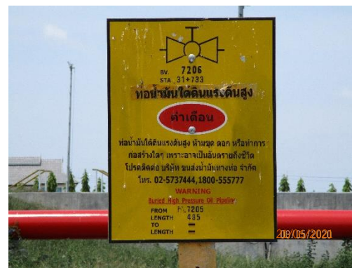
รูปที่ 2-12 การตรวจสอบและป้ายแสดงตำแหน่ง Block Valve
