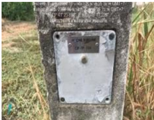
รูปที่ 2-13 (ต่อ) งานบำรุงรักษา Cathodic Protection
