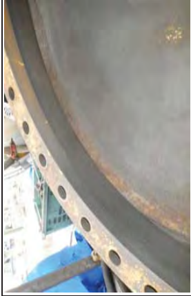
Pic. No. 16 Location : Floating Head Cover Description : สภาพโดยรวมของ Floating head เป็นปกติ ไม่พบความเสียหาย
