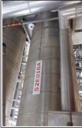
Pic. No. 10 Location : Shell (External) Description : สภาพโดยรวมของ Cladding & Silicone sealing เป็นปกติ ไม่พบความเสียหาย
