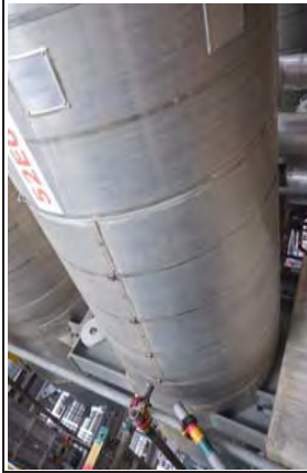
Pic. No. 9 Location : Shell (External) Description : สภาพโดยรวมของ Cladding & Silicone sealing เป็นปกติ ไม่พบความเสียหาย
