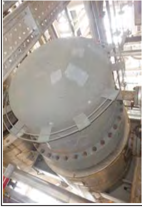
Pic. No. 13 Location : Shell Cover (External) Description : สภาพโดยรวมของ Shell cover เป็นปกติ ไม่พบความเสียหาย
