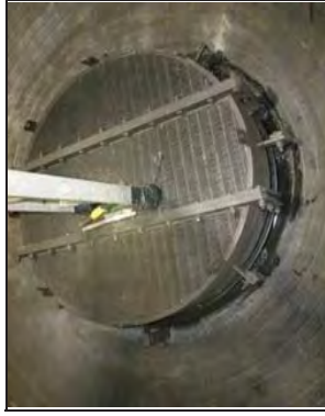
Pic. No. 25 Location : Outlet Collector (Internal) Description : สภาพโดยรวมของ Outlet Collector เป็นปกติ ไม่พบความเสียหาย
