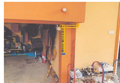
หมุดวัดการทรุดตัวของอาคาร BS32
