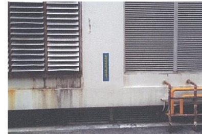
หมุดวัดการทรุดตัวของอาคาร BS5
