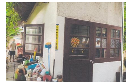
หมุดวัดการทรุดตัวของอาคาร BS23
