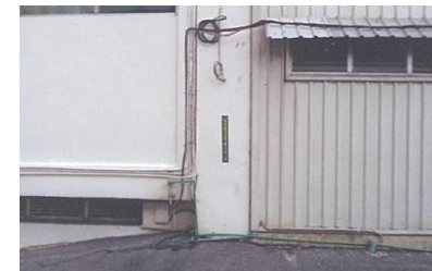
หมุดวัดการทรุดตัวของอาคาร BS3
