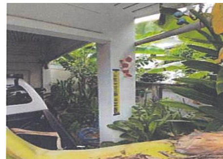
หมุดวัดการทรุดตัวของอาคาร BS44
