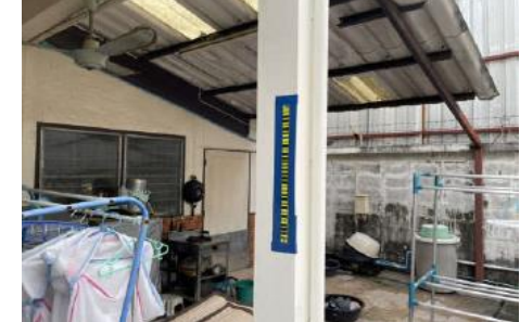
หมุดวัดการทรุดตัวของอาคาร BS55
