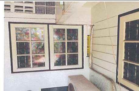
หมุดวัดการทรุดตัวของอาคาร BS40
