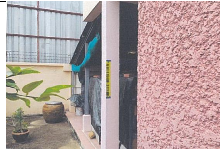
หมุดวัดการทรุดตัวของอาคาร BS34
