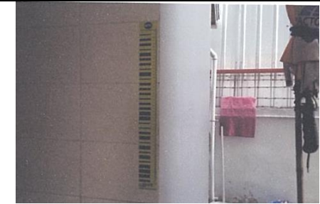
หมุดวัดการทรุดตัวของอาคาร BS17
