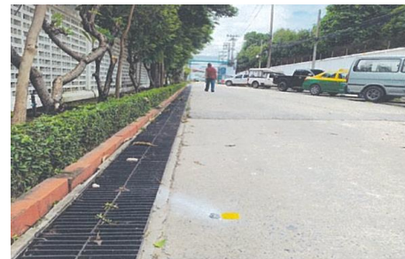
หมุดวัดการทรุดตัวของพื้น GS4
