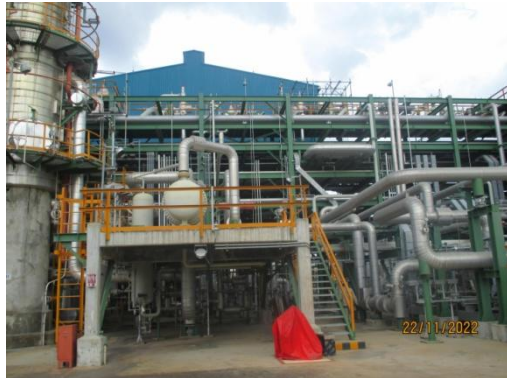
รูปที่ 3.2-50 Concrete Fireproofing
