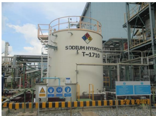
รูปที่ 3.2-15 เขื่อน (Curb) ล้อมรอบพื้นที่เก็บ และ การสูบน้ำสารเคมี และบริเวณพื้นที่การผลิต
