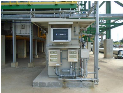
รูปที่ 3.2-1 Continuous Emission Monitoring System, CEMS (โรงผลิตสาร โอเลฟินส์ โรงที่ 1/2)
