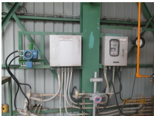
รูปที่ 3.2-65 Chlorine Gas Detector
