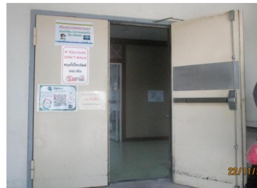
รูปที่ 3.2-49 ประตูชนิด Double Door & Airlock
