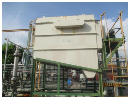
รูปที่ 3.2-10 DOX Separator
