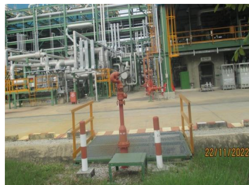
เครื่องดับเพลิงชนิด Fixed Monitor
