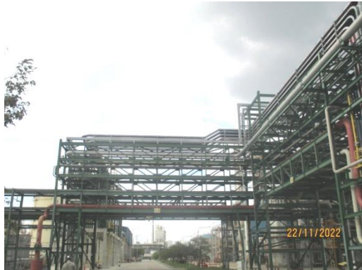
รูปที่ 3.2-59 Pipe Rack รองรับท่อรับวัตถุดิบ
