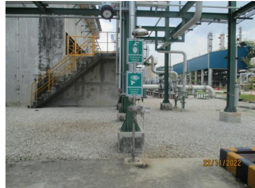
รูปที่ 3.2-40 ฝักบัวฉุกเฉินและที่ล้างตา (Safety Shower)
