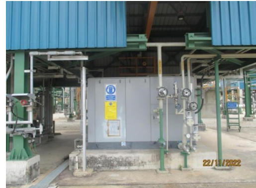
รูปที่ 3.2-34 ฝากรอบเครื่องจักรเพื่อลดระดับเสียง จากแหล่งกำเนิด
