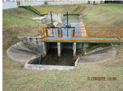
รูปที่ 3.1-13 บ่อดักตะกอน บริเวณรางระบายน้ำฝน
