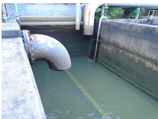
รูปที่ 3.2-19 Recovered Water Pit
