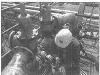
รูปที่ 11, 12 แสดงการทดสอบลิ้นวาล์ว
