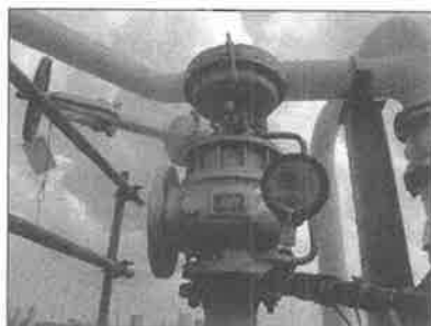
รูปที่ 7, 8 แสดงการทดสอบลิ้นวาล์วประจำถัง
