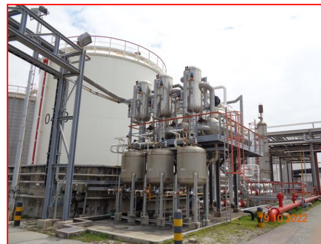
ภาพที่ 2.3-43 Vent Condensing Unit
