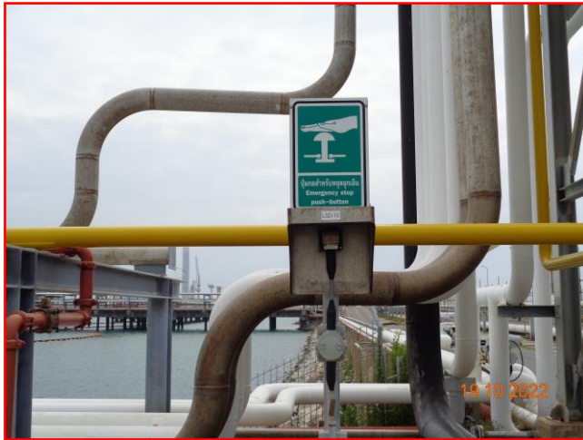
ภาพที่ 2.3-32 ปุ่มหยุดฉุกเฉินขณะ Load สารเคมี
