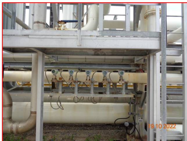
ภาพที่ 2.3-42 Pressure Transmitter
