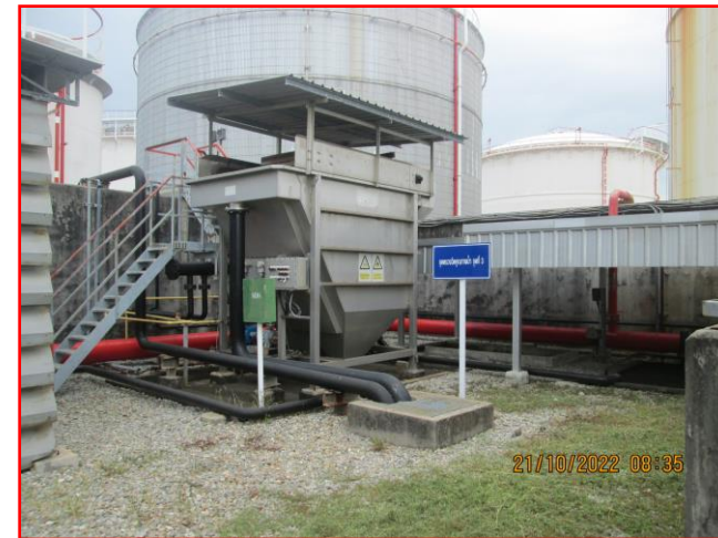
ภาพที่ 2.3-10 Oil-Water Separator
