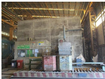
ภาพที่ 2-7 ห้องครอบเสียง/การติดตั้งวัสดุดูดซับ
