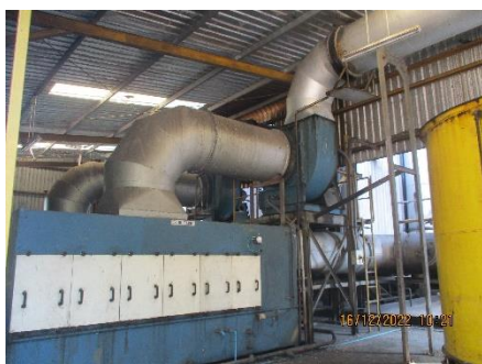
ภาพที่ 2-2 ระบบดักไอน้ำมัน (Oil Circulation)
