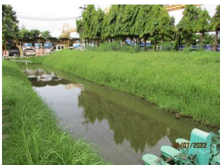
ภาพที่ 2-16 บ่อพักน้ำทิ้งขนาด 600 ลูกบาศก์เมตร
