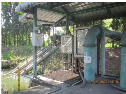
ภาพที่ 2-18 pump สูบน้ำฝนออกนอกโครงการ
