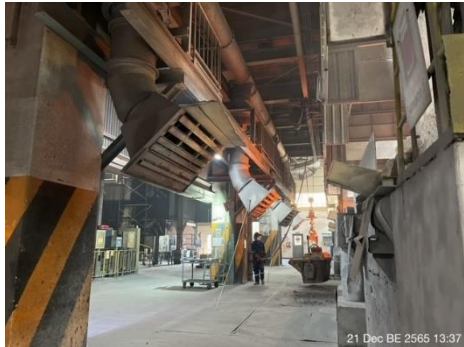
ภาพที่ 2-1 ระบบรวบรวมฝุ่นแบบ Canopy hood
