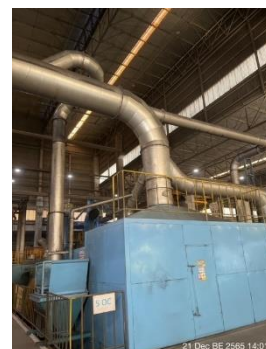
ภาพที่ 2-30 ระบบดูดอากาศ (ระบบปิด) ในบริเวณที่มี กระบวนการทำแบบทราย
