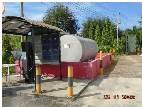
ภาพที่ 2-29 คันคอนกรีตป้องกันสารเคมีรั่วไหล รอบลานถังเก็บน้ำมันดีเซล
