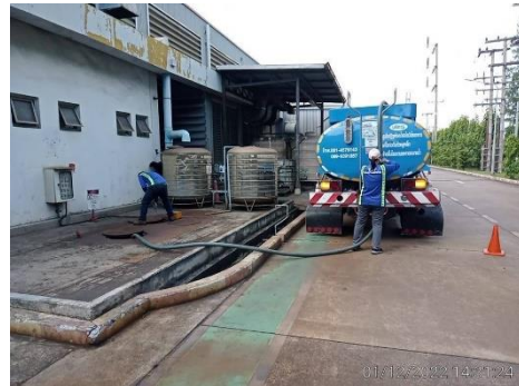
ภาพที่ 2-32 การดูแลทำความสะอาดถึงบำบัด น้ำเสียสำเร็จรูป
