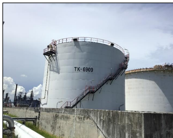
รูปที่ 2-3 ถัง Isomerization Benzene
