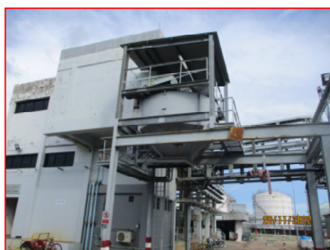
(35) ถัง 10 ตันรวบรวมกากตะกอนจาก ระบบบำบัดน้ำเสีย
