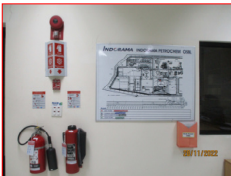
(55) Fire Extinguisher ชนิด ABC Dry Chemical และชนิด CO 2
