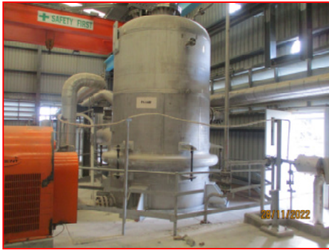
(9) Scrubber และ Condenser บริเวณ PTA Dryer Scrubber
