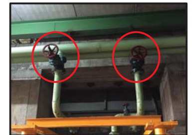
14. เปิดวาล์วระบายความร้อนของเครื่องเทอร์โบไนน์
