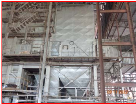
ภาพที่ 2.2-5 อุปกรณ์ดักฝุ่น แบบ Multi Cyclone
