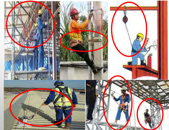
การทำงานในที่สูง เราผูกยึดตัวของเราเข้ากับโครงสร้างที่มั่นคง
