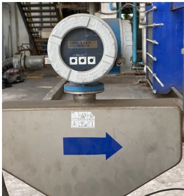
ภาพที่ 51 อุปกรณ์ตรวจวัดปริมาณหรืออัตราการไหลของเมทานอล อากาศ และน้ำ
