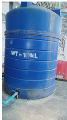
ภาพที่ 2-17 ถังพักน้ำทิ้งฉุกเฉินขนาด 10 ลูกบาศก์เมตร
