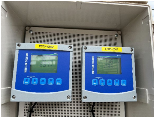
ภาพที่ 2-23 อุปกรณ์ตรวจวัดค่าความนำไฟฟ้า แบบอัตโนมัติ
