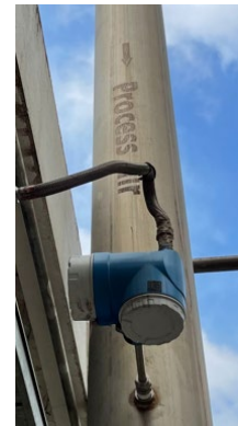
ภาพที่ 51 อุปกรณ์ตรวจวัดปริมาณหรืออัตราการไหลของเมทานอล อากาศ และน้ำ
