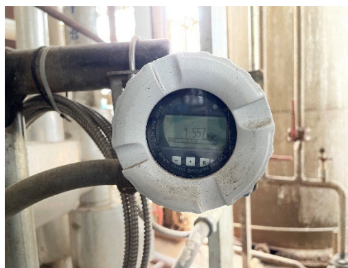
ภาพที่ 2-56 เครื่องตรวจวัดความดันที่ท่อขนส่งสารเคมี
