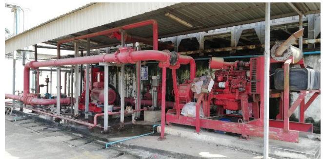
ภาพที่ 2-58 เครื่องสูบน้ำดับเพลิงและถังเก็บน้ำสำรองดับเพลิง
