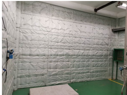
ภาพที่ 2-8 วัสดุดูดซับเสียงภายในอาคารเครื่องอัดอากาศ
