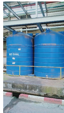
ภาพที่ 2-14 ถังพักน้ำทิ้ง 20 ลูกบาศก์เมตร
