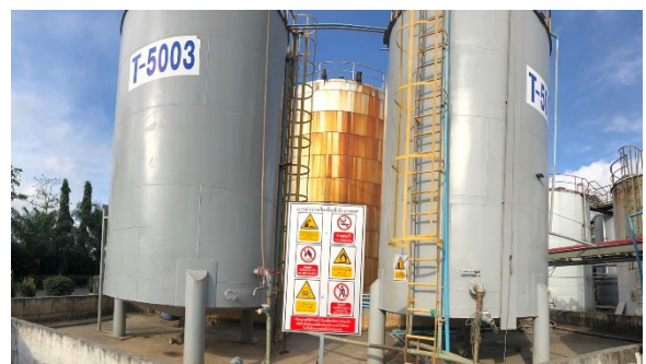
ภาพที่ 2-21 ถังพักน้ำเสียขนาด 90 ลูกบาศก์เมตร
