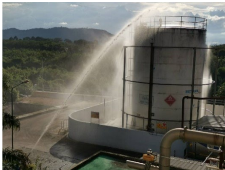
ภาพที่ 2-48 ระบบ Deluge Sprinkler และ Fire Detector ที่ถังเก็บกากเมทานอล
