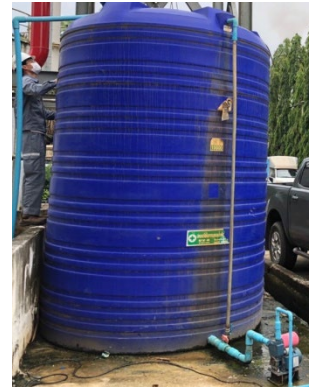
ภาพที่ 2-11 ถังพักน้ำทิ้งขนาด 10 ลูกบาศก์เมตร
