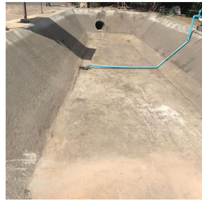
ภาพที่ 2-24 บ่อหน่วงน้ำขนาด 100 ลูกบาศก์เมตร
