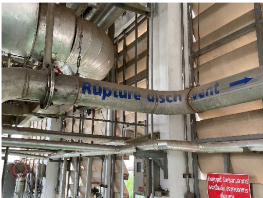
ภาพที่ 2-52 Rupture Disc
