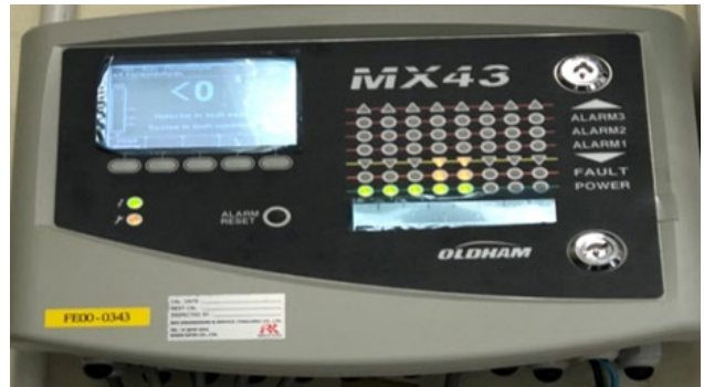
ภาพที่ 2-46 เครื่องตรวจวัดการรั่วของฟอร์มัลดีไฮด์แบบต่อเนื่อง (Gas Detector)
