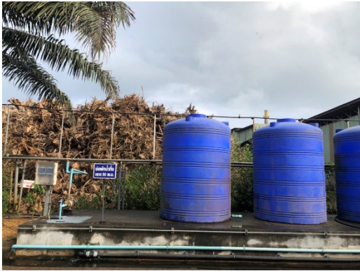
ภาพที่ 2-15 ถังพักน้ำเสียขนาด 50 ลูกบาศก์เมตร
