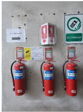
ภาพที่ 2-57 (ต่อ) อุปกรณ์แจ้งเตือนและระงับอัคคีภัย
