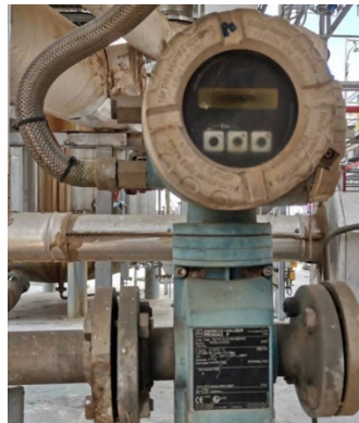
ภาพที่ 51 อุปกรณ์ตรวจวัดปริมาณหรืออัตราการไหลของเมทานอล อากาศ และน้ำ
