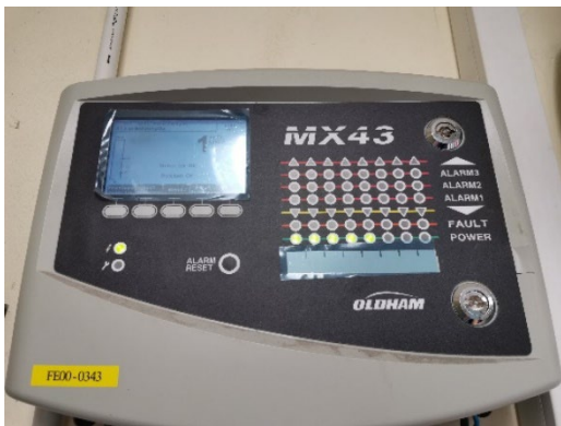
ภาพที่ 2-5 เครื่องตรวจวัดการรั่วของฟอร์มัลดีไฮด์แบบต่อเนื่อง (Gas Detector)
