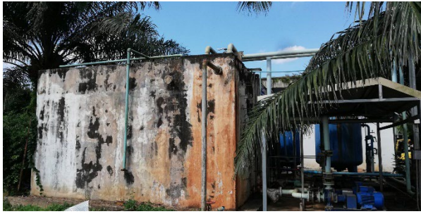
ภาพที่ 2-34 บ่อพักน้ำบาดาลขนาด 60 ลูกบาศก์เมตร
