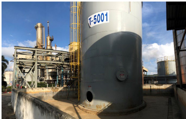
ภาพที่ 2-13 ถังพักน้ำเสียขนาด 120 ลูกบาศก์เมตร
