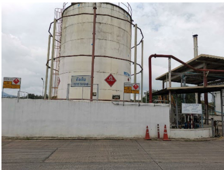
ภาพที่ 2-20 คันคอนกรีตกั้นน้ำบริเวณลานถังเก็บกักสารเคมี
