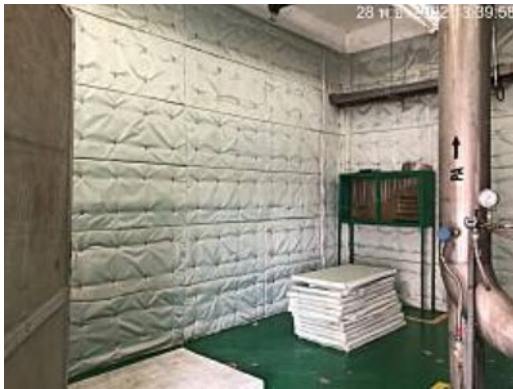
ภาพที่ 2-8 วัสดุดูดซับเสียงภายในอาคารเครื่องอัดอากาศ
