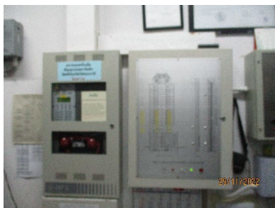
ระบบเตือนไฟไหม้และ Indicator Lamp
