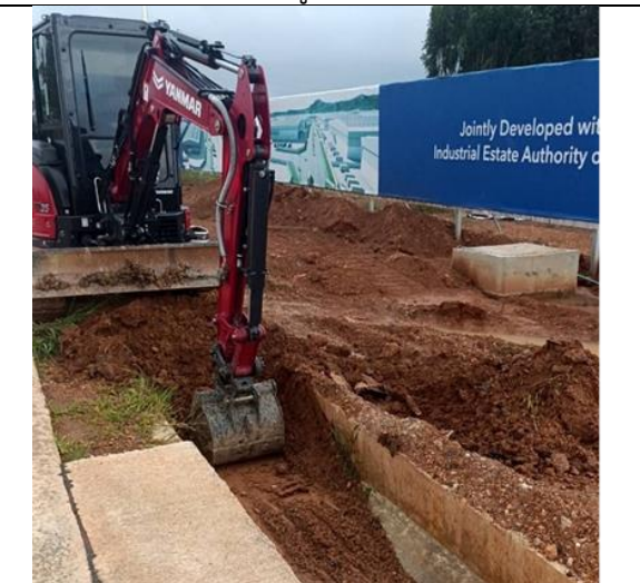
ภาพที่ 36 ขุดลอกตะกอนดิน
