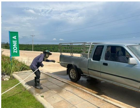
ภาพที่ 19 พื้นที่ล้างเครื่องมือ เครื่องจักร และล้อรถ
