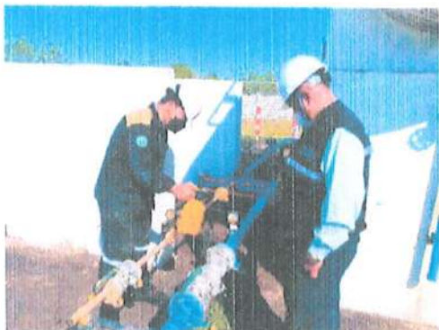
รูป การตรวจสอบการรั่วซึมระบบท่อ
