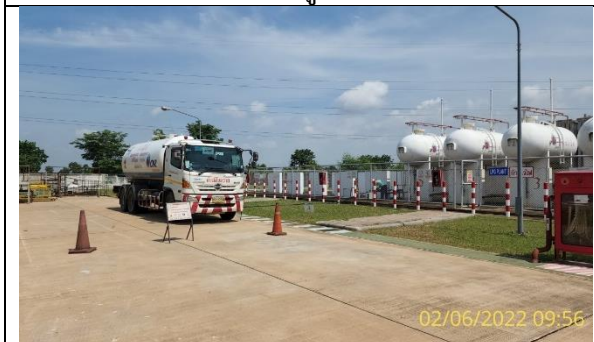
รูปที่ 2-46 การกำหนดเขตและปิดกั้นรอบพื้นที่ ปฏิบัติงานบริเวณถังเก็บก๊าซปิโตรเลียมเหลว
