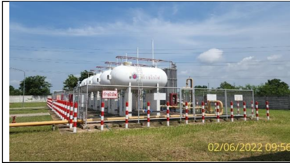
รูปที่ 2-44 ขอบเขตรั้วรอบพื้นที่ถังเก็บก๊าซปิโตรเลียมเหลว
