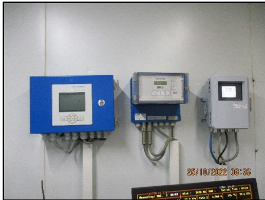
ภาพที่ 2.3 อุปกรณ์การตรวจวัดก๊าซแบบ Online
