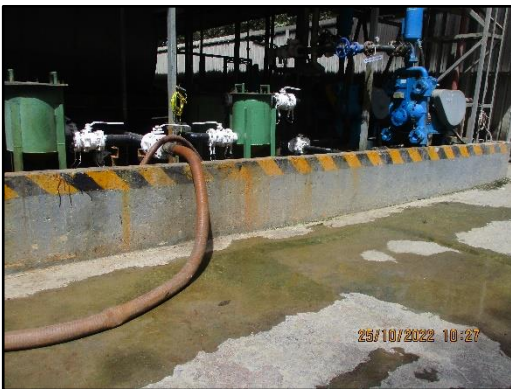
ภาพที่ 2.15 คันคอนกรีต (Bund Wall) รอบถังกักเก็บของเสียที่เป็นของเหลว
