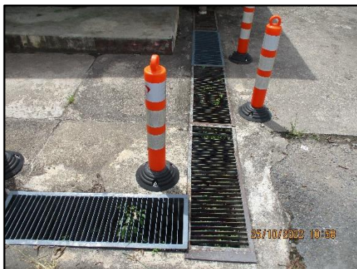
ภาพที่ 2.11 บ่อดักไขมันและน้ำมัน
