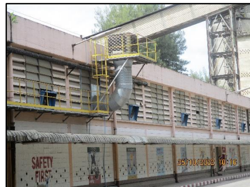
ภาพที่ 2.53 ระบบระบายอากาศเฉพาะที่
