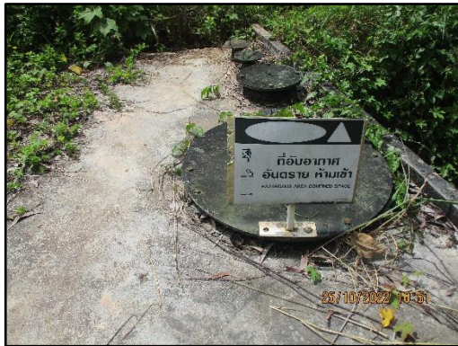
ภาพที่ 2.11 บ่อดักไขมันและน้ำมัน
