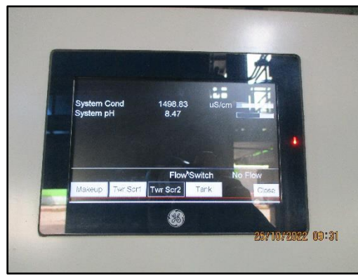
ภาพที่ 2.16 การติดตั้งเครื่องตรวจวัดคุณภาพน้ำอัตโนมัติก่อนระบายน้ำทิ้งจากหอหล่อเย็นลงสู่บ่อพักน้ำ 200,000 ลบ.ม.
