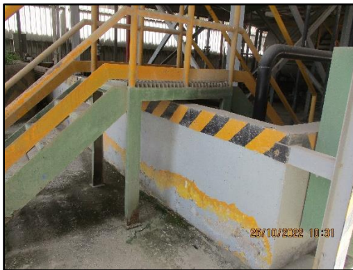
ภาพที่ 2.15 คันคอนกรีต (Bund Wall) รอบถังกักเก็บของเสียที่เป็นของเหลว
