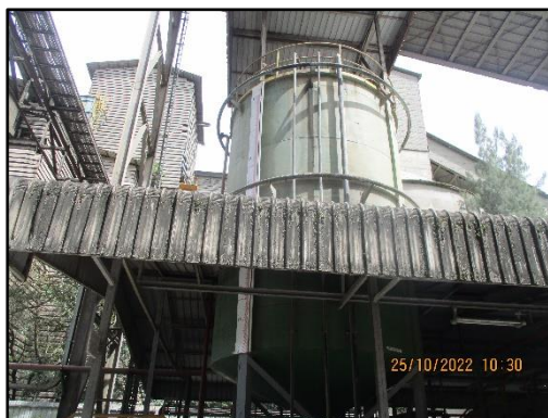
ภาพที่ 2.63 ถังเก็บของเสียที่เป็นของเหลวของโครงการ
