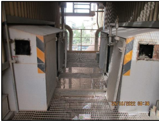
ภาพที่ 2.27 Casing หุ้มชุด Hammering Equipment
