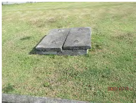
ภาพที่ 2.4 ป่อพักน้ำเสีย (Manhole)
