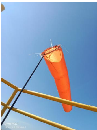
รูปที่ 23 การติดตั้งถุงลม (Wind Sock) บริเวณลานกองเก็บเถ้า
