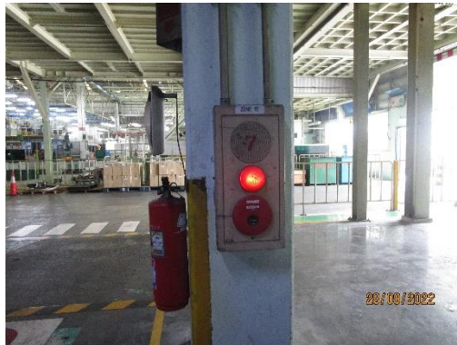
รูปที่ 40 สัญญาณแจ้งเหตุเพลิงไหม้อัตโนมัติ และปุ่มกดแจ้งเหตุเพลิงไหม้
