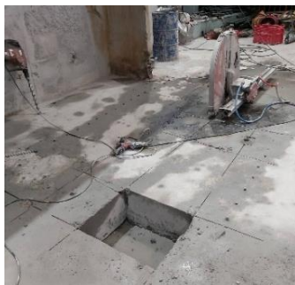
รูปที่ 4 การใช้เครื่องตัดพื้นปูน
