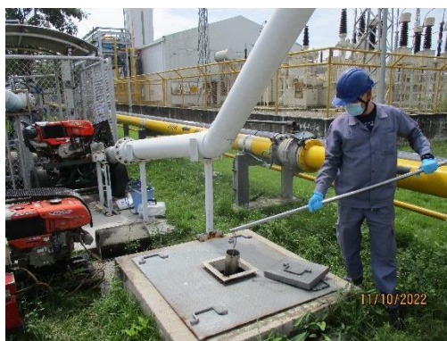
รูปที่ 5 บ่อพักน้ำสุดท้ายก่อนปล่อยสู่ระบบบำบัดน้ำเสียส่วนกลางในนิคมอุตสาหกรรม
