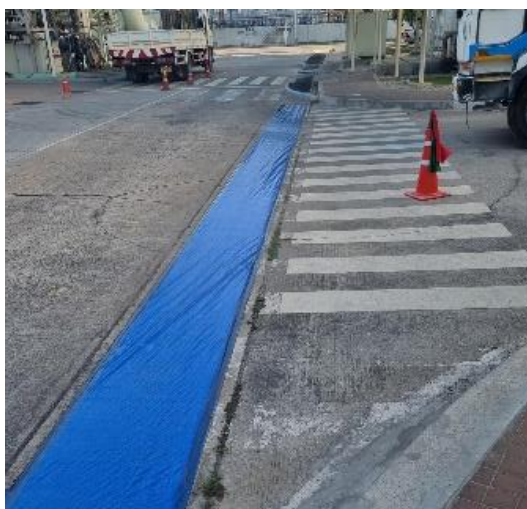
รูปที่ 8 การปิดคลุมรางระบายน้ำ
